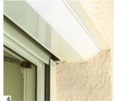
Abb. 4: Außenliegende Revisionsklappe aus stranggepresstem Aluminium.
